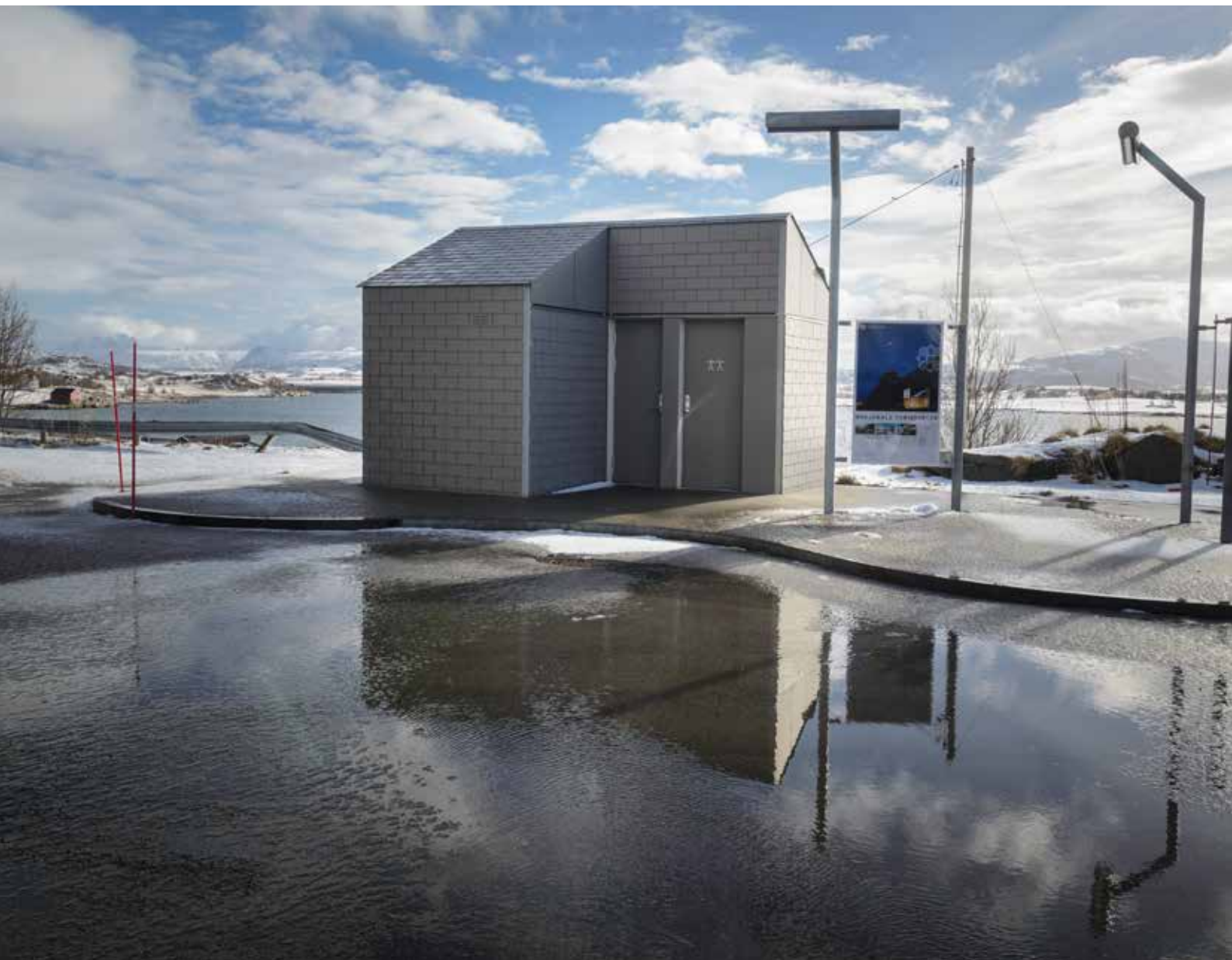
Skreda rasteplass med toalettbygg og informasjonstavle. Foto: Steinar Skaar.
